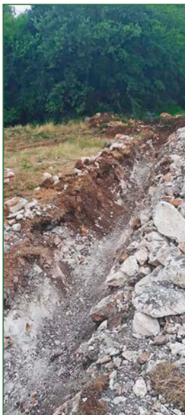
Vodovodni kanal za potrebe nogometnog igrališta
