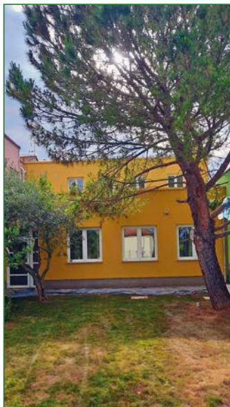
Saniran je dio fasade vrtića Kalimero u Brtonigli
